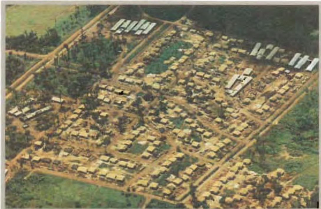
② Margen derecha - Conjunto habitacional - 31/12/75
