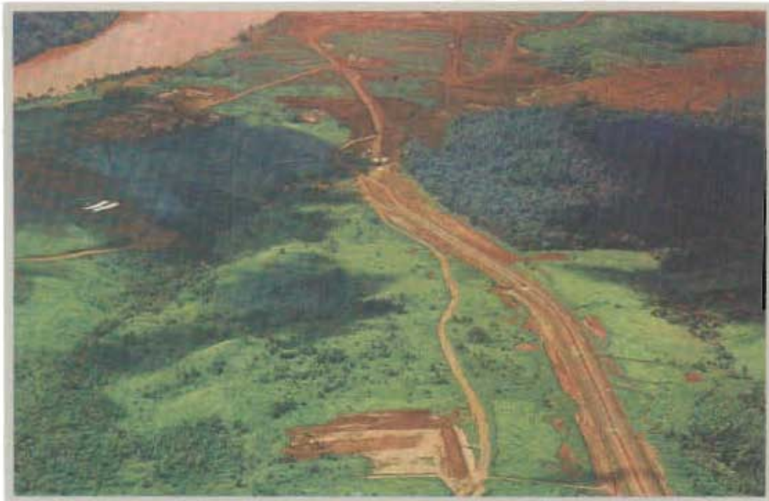
Carretera de acceso - Foz do Iguaçu/Obrador
