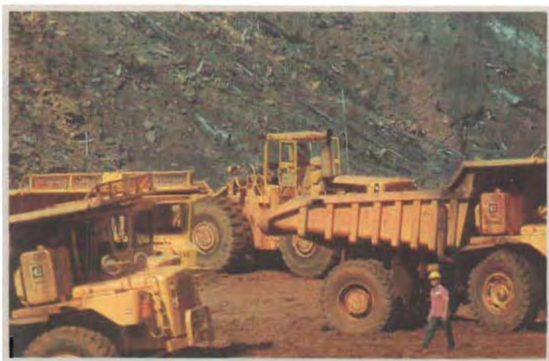
Operaciones de limpieza y desmonte
